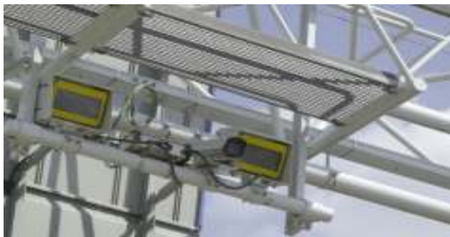
figuur 2-2 Reistijdcamera's aan portalen boven de weg verzamelen voertuigenkentekens.
